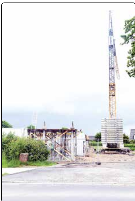
Die Baustelle in der Ortsmitte
