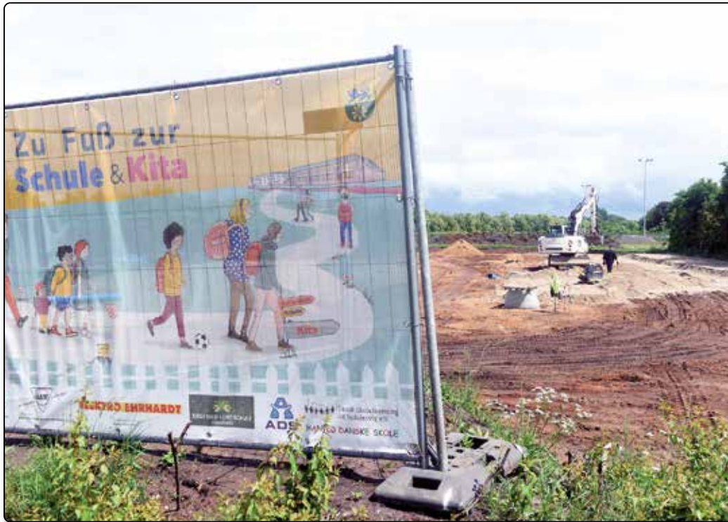
Stand der Baustelle Ende Mai. Foto: Ki
