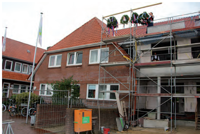
Die Richtkränze wurden zwischen Altbau und Neubau (r.) platziert
