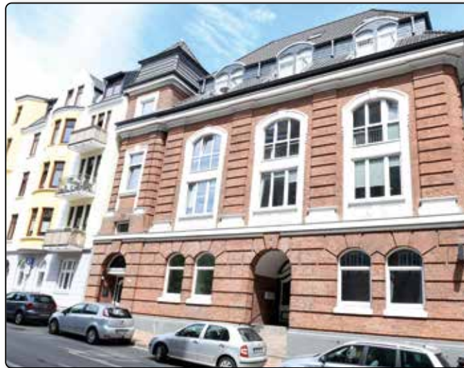
Nordergraben 70: Das einstige „Hotel am Stadtpark“
