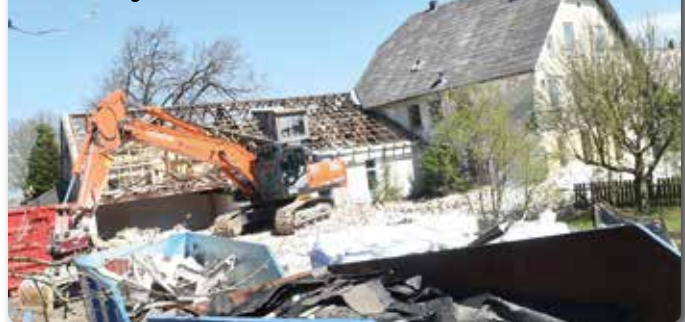
Der Abriss begann von hinten
