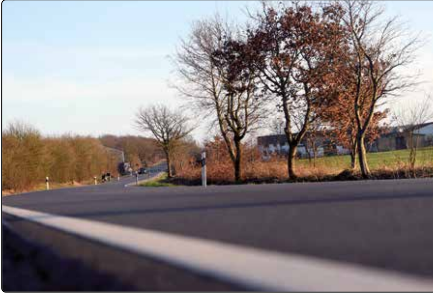
Die L96 wurde im letzten Jahr saniert. Fotos: Ki.
