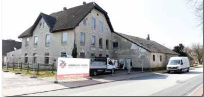
Das Gebäude kurz vor dem Abriss
