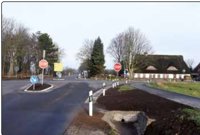
Komplett saniert: die Hülleruper Kreuzung.
