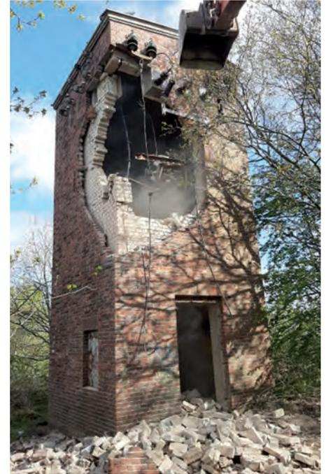
Ende April wurde die letzte verbliebene Strom-Freileitung auf Ahrenshöfter Gebiet von der Schleswig-Holstein Netz AG zurückgebaut. Insgesamt wurden zwischen Ahrenshöft und Arlewatt auf einer Länge von 2300 Metern 16 Betonmasten, 2 Gittermasten und die Turmstation
