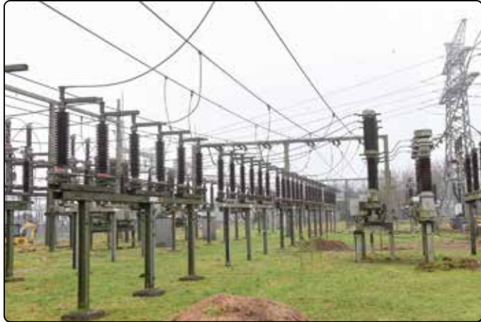
Die alte Technik und ein altes Betriebsgebäude sollen abgerissen werden.
