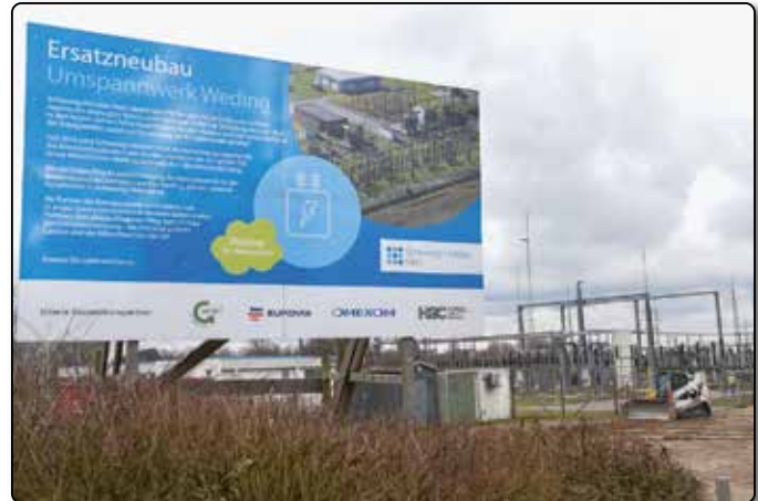
Die Baumaßnahme wird an der Straße beworben.
