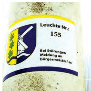
jetzt eine Karte des Ortes zur Verfügung steht, in der jede Straßenlaterne eingetragen ist. Außerdem wurden gut sichtbare Aufkleber an den Laternen angebracht. Jede Leuchte hat eine eigene Nummer erhalten, die bei Störungsmeldungen möglichst mit angegeben werden sollte. Die Laterne ist dann schneller zu finden, und der Fehler ist eher behoben. Zusätzlich wird
