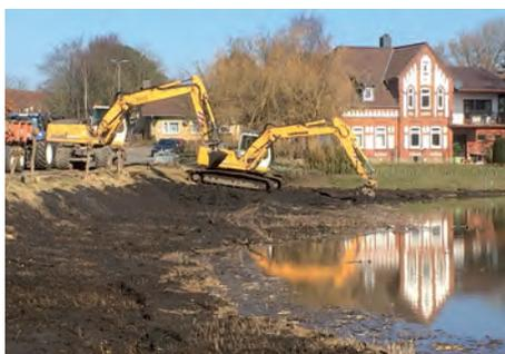
Wurzelwerk und den Schlamm im Uferbereich auf ca. 100 Meter zu entfernen. Nach dem Baggern wurde das Gut zunächst im Uferbereich zwischengelagert und getrocknet und anschließend zur weite-
