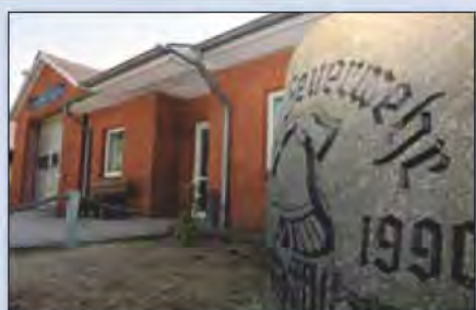
Feuerwehrgerätehaus Haurup, Deverseering 7
