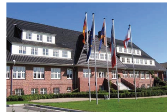
Das Amtsgebäude in Bredstedt
